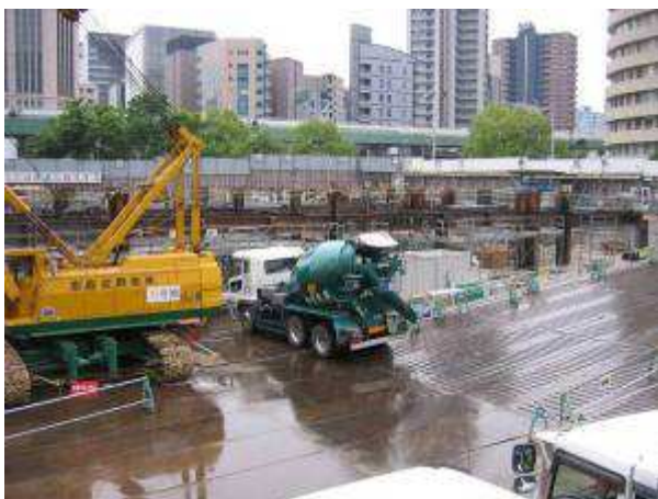
写真3 車両通行路の鉄板敷き (粉じんの発生・飛散防止)
