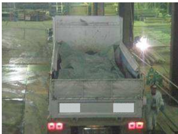
写真5 掘削残土積荷のシートカバー掛け (飛散防止)
