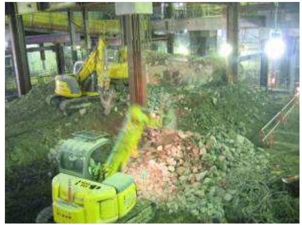
写真8 場内で発生したコンクリートガラの活用 (車両台数の削減、リユースの実施等)
