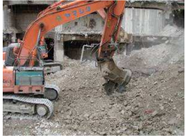
写真10 解体工事でのガラ小割り (廃棄物の分別)
