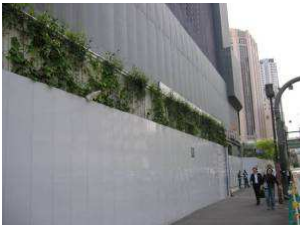
写真1 仮囲い(鋼鉄 3.0m+シート 1.2m)及び 上部緑化(親緑性への配慮)
