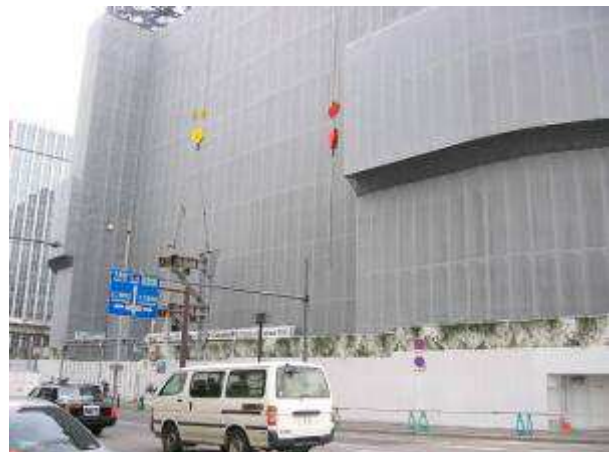
写真12 四つ橋筋側への工事用ゲートの追加 (交通対策)
