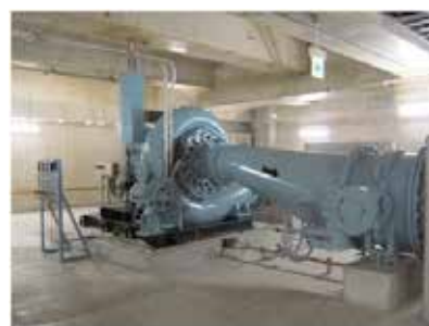
長居配水場の水力発電設備
