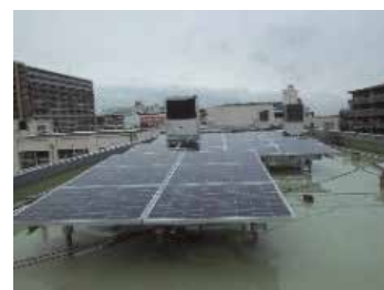
屋上に設置した太陽光発電設備
