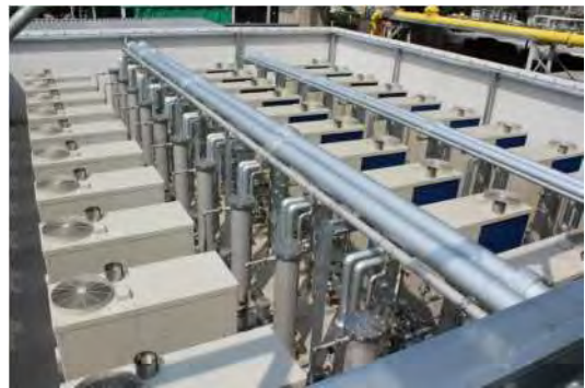
図 2 - 14 消化ガス発電施設（大野下水処理場）
