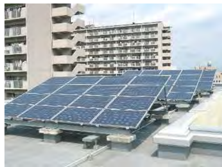
図2-7 太陽光発電設備（柴島浄水場、250kW） 図2-8 太陽光発電設備（焼野小学校、10kW）
