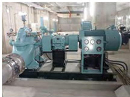
図 2 - 20 小水力発電設備（泉尾配水場）
