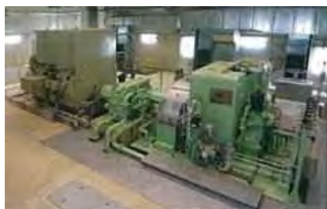
図2-10 発電設備(東淀工場)
