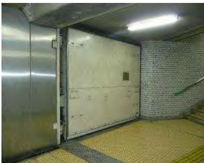
図 3 - 16 出入口止水扉（地下鉄）
