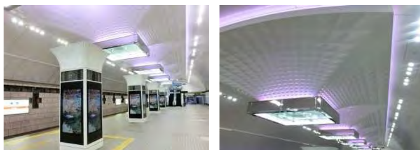
図2 - 37 LED照明（大阪市営地下鉄梅田駅）
