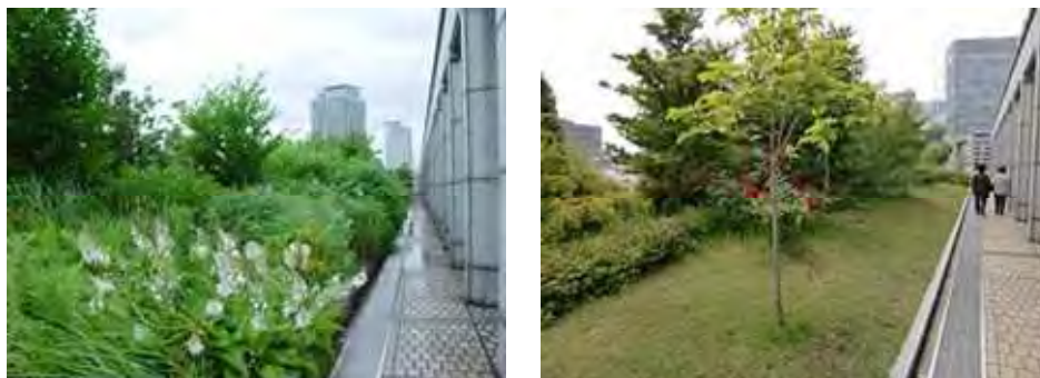
図 2 - 41 大阪役所本庁舎の屋上緑化施設
