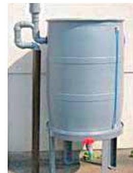
■雨水貯留タンク（一例）
