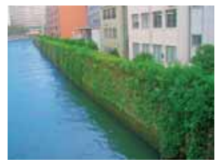
■護岸緑化（筑前橋から肥後橋）
