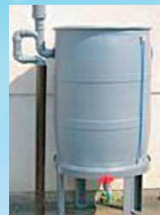
雨水貯留タンク
