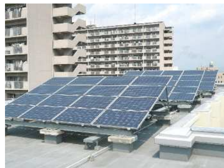
図2-8 太陽光発電設備（焼野小学校、10kW）
