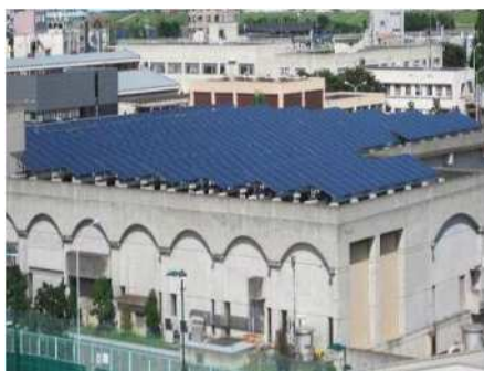
図2-7 太陽光発電設備（柴島浄水場、250kW）
