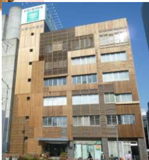
建築部壁面における木材利用 (大阪木材会館)
