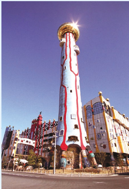
舞洲工場外観
