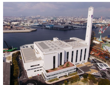
大阪広域環境施設組合 住之江工場(令和5年3月竣工)
