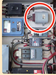
低分分電盤内の 低圧コンデンサー
