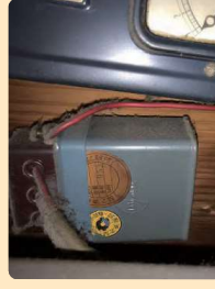
配電盤に設置された 低圧コンデンサー
