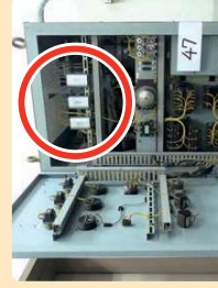
可変周波数電源装置に 取り付けられた低圧コンデンサー
