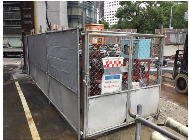
写真4 PH中和装置設置状況
