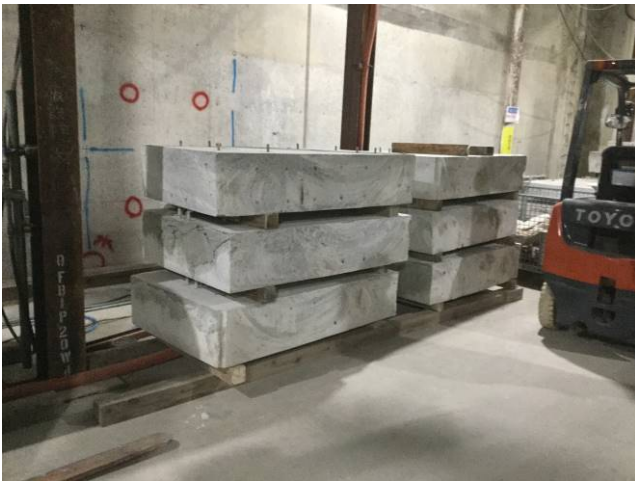
写真3 ワイヤソーによる躯体解体状況
