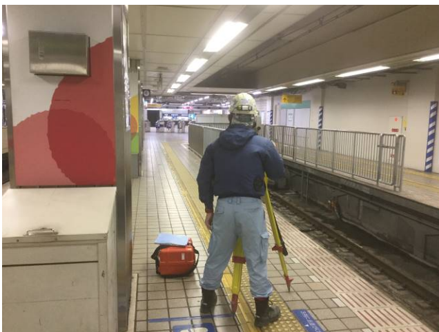
写真5 近接鉄道躯体計測状況
