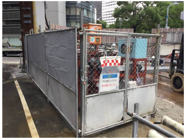
写真4 PH中和装置設置状況
