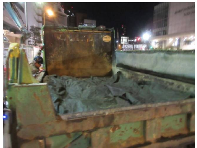
写真6 汚染土シート掛け状況
