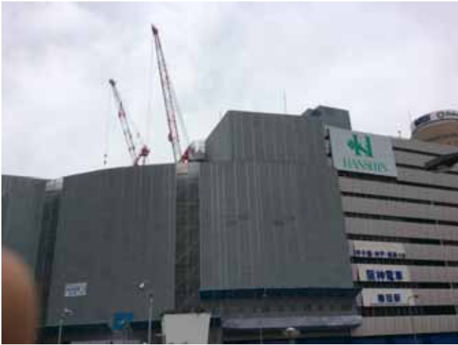
写真1 仮囲いの設置状況
