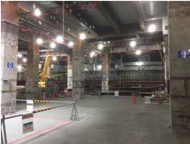
写真3 地下逆打ち工法施工状況
