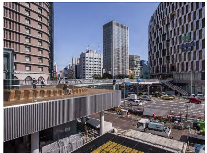
写真 14 歩行者デッキ（歩道橋）
