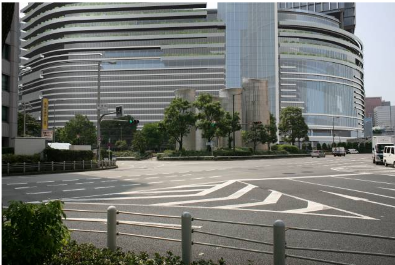
図 5-13-4(2) 富国生命ビル前からの景観（施設完成後）
