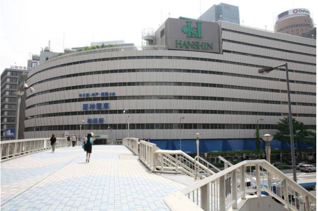
図 5-13-2(1) 梅田新歩道橋中央からの景観（現況）
