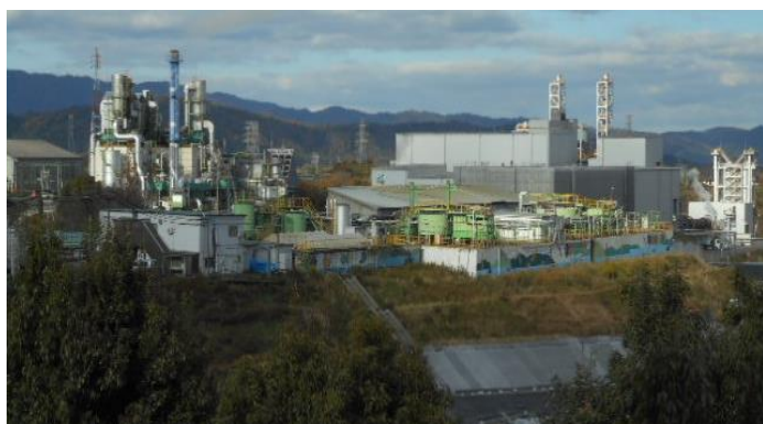
リサイクルセンター敷地内の高台より施設を望む（一部風景）
