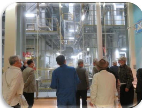
排ガス処理設備
