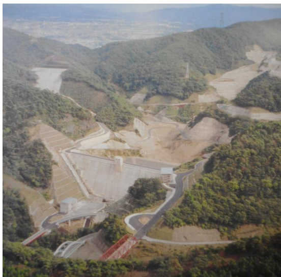
埋立て処分地全景（パンフレットより記載）
