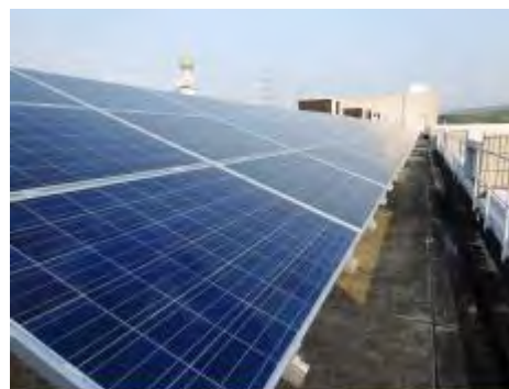
大阪府立南大阪高等職業技術専門学校（和泉市）
