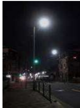
（参考）道路照明灯のLED照明
