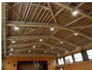
LED照明(港中学校:港区)
