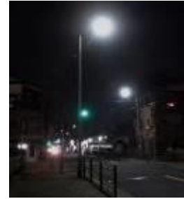
道路照明灯のLED照明
