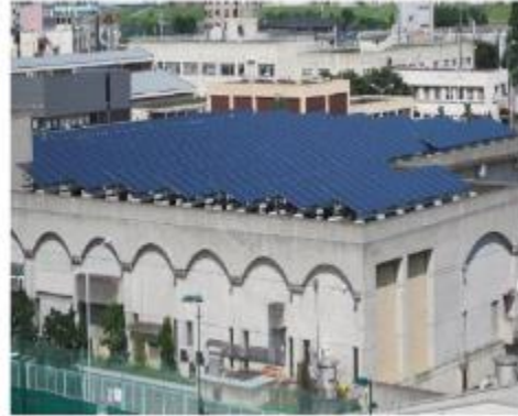
【高度浄水処理棟】
