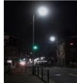
道路照明灯のLED照明
