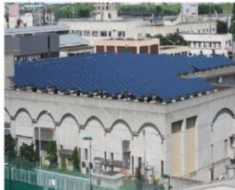
【高度浄水処理棟】
