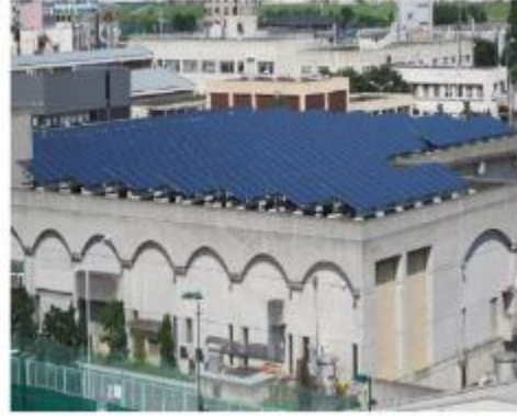
【高度浄水処理棟】
