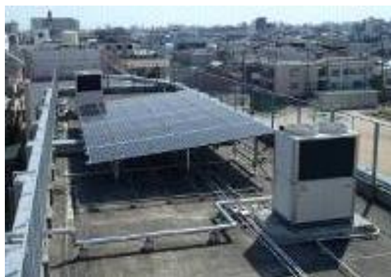
太陽光発電設備設置（大池小学校：生野区）
