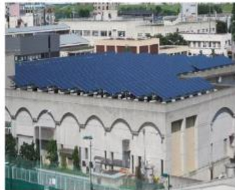
【高度浄水処理棟】
