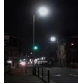
道路照明灯のLED照明
