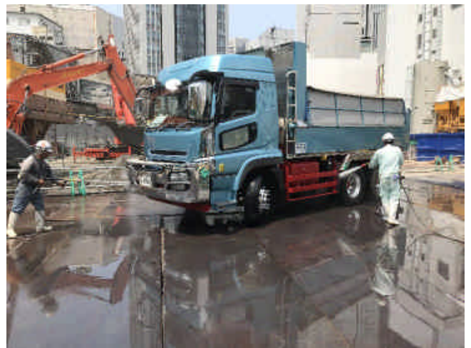
写真4：タイヤ洗浄状況
