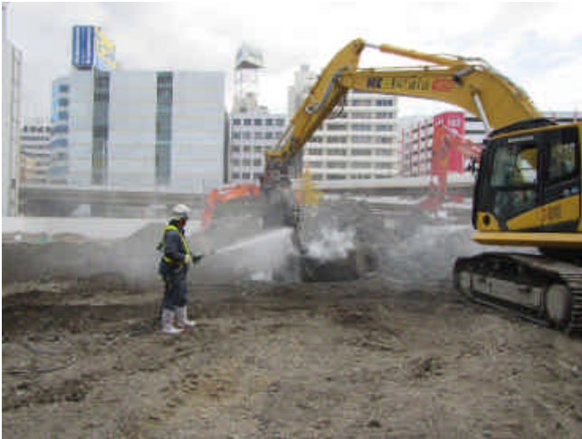
写真1：解体作業時の散水
