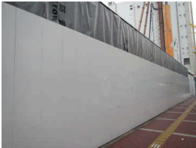
写真3：仮囲い+上部シート設置状況
