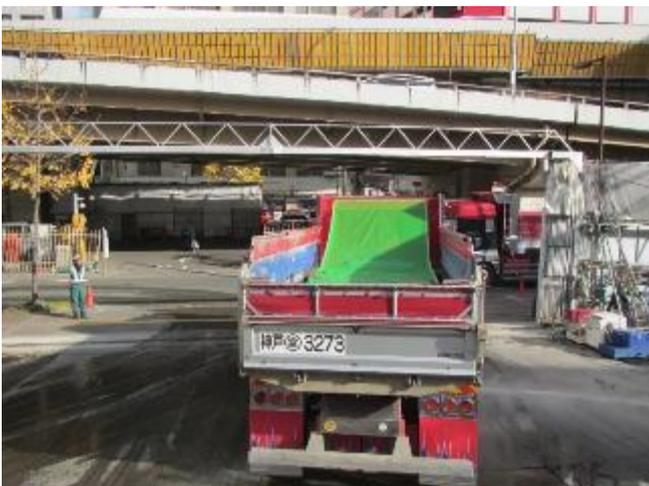
写真5：ダンプ搬出土シート養生
