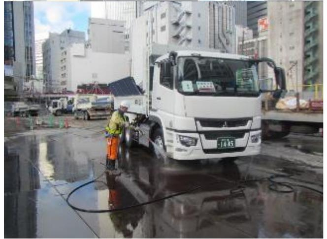
写真2：タイヤ洗浄・敷鉄板
