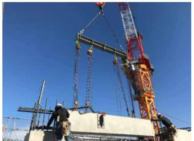
写真6：PC部材取り付け
