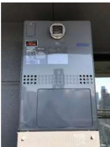
写真 17：高効率給湯設備（住宅専有部）
