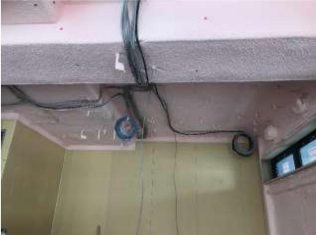
写真 13：高断熱材の採用（住宅共用部）
