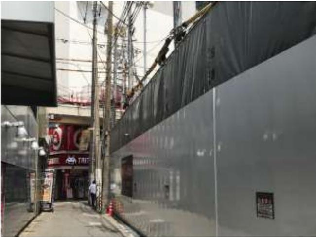
写真7：仮囲い、上部シート設置状況
