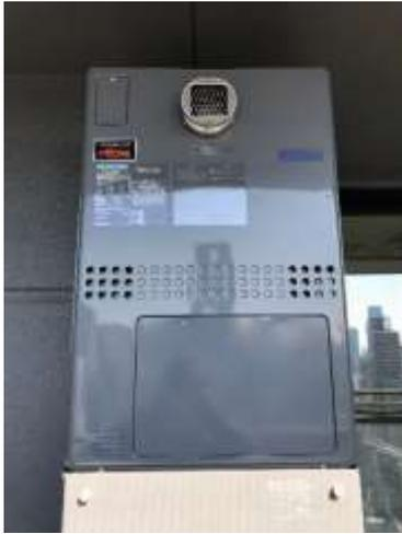
写真 19：高効率給湯設備（住宅専有部）
