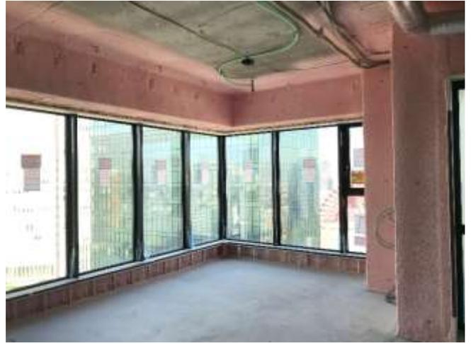
写真 16 : 高断熱材の採用 (住宅専有部)
