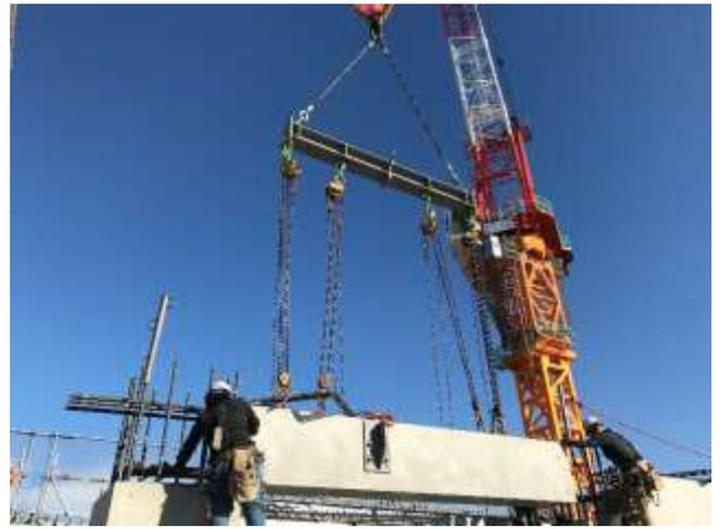
写真8：P C部材取り付け
