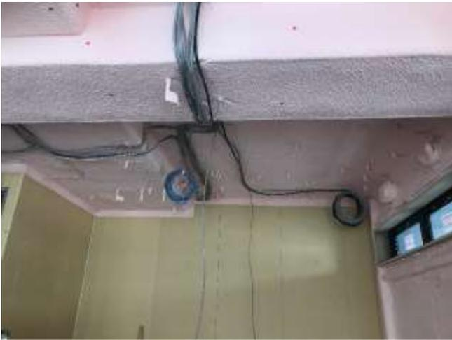
写真 15 : 高断熱材の採用 (住宅共用部)
