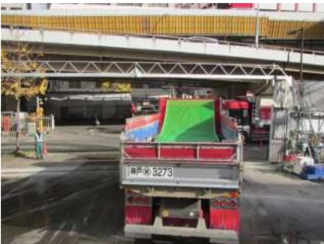
写真5：ダンプ搬出土シート養生
