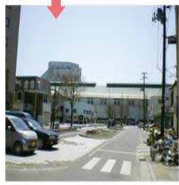
2011.5 災害廃棄物撤去後 (岩手県釜石市大町付近)
