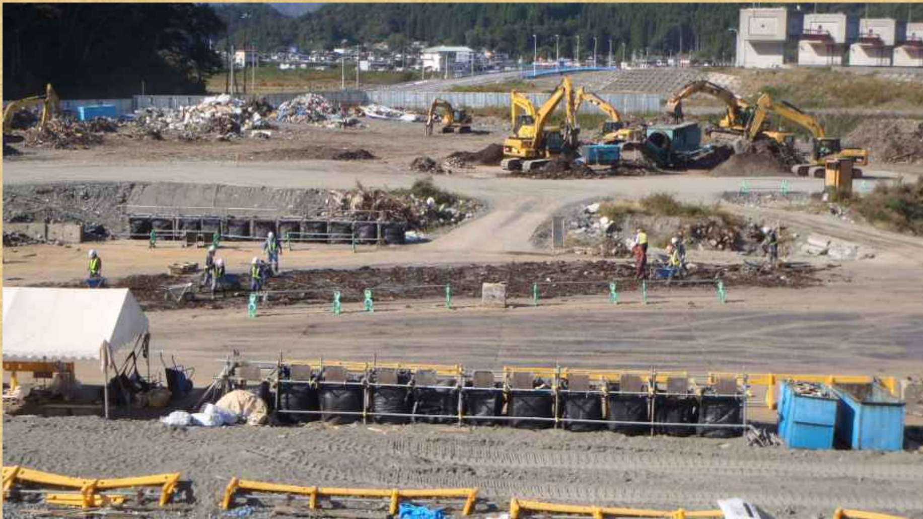
岩泉町仮置場
