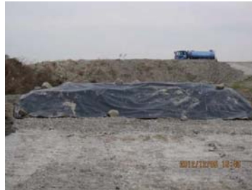
埋立完了後のシート保護状況
