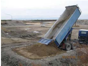
埋立作業状況
