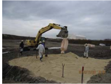
ゼオライト敷設状況
