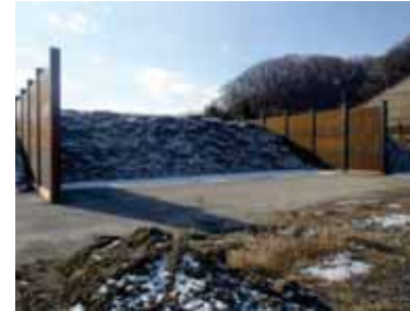
《大阪府専用ストックヤード》 （宮古港藤原埠頭内）
