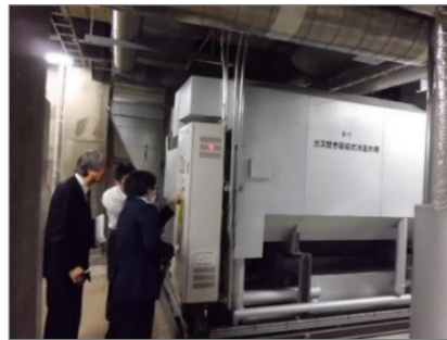
↑機器類の現地確認の様子
