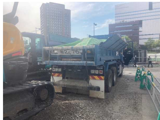
写真 8.6 荷台へのシート掛け
