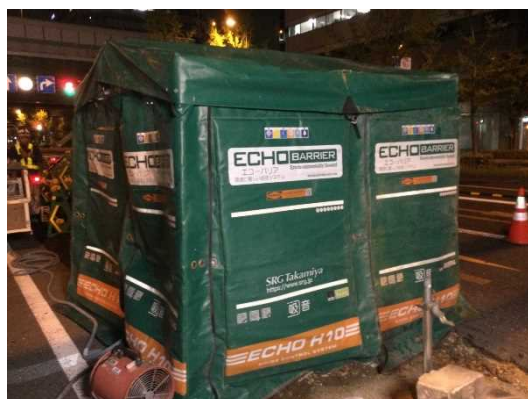
写真 8.7 防音シート設置状況
