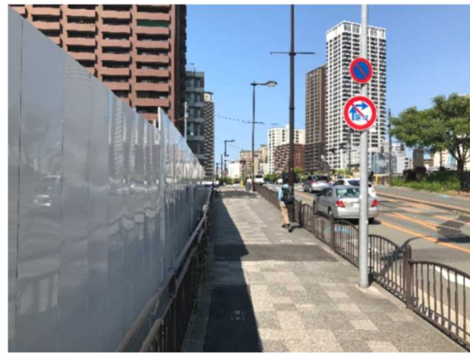
写真 8.4 万能塀設置状況
