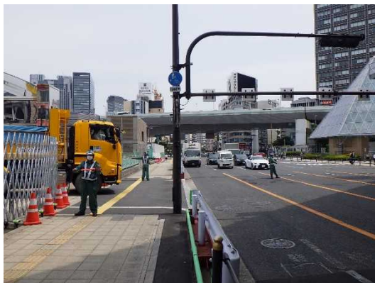
写真 8.3 交通誘導員配置状況
