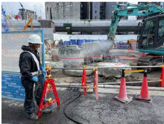
写真 8.5 散水状況
