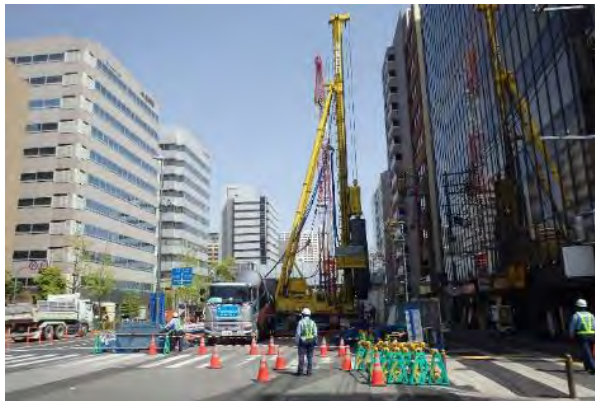
写真 8.11 土留工 (SMW 工法) 施工状況
