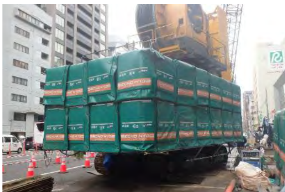
写真 8.7 防音シート設置状況
