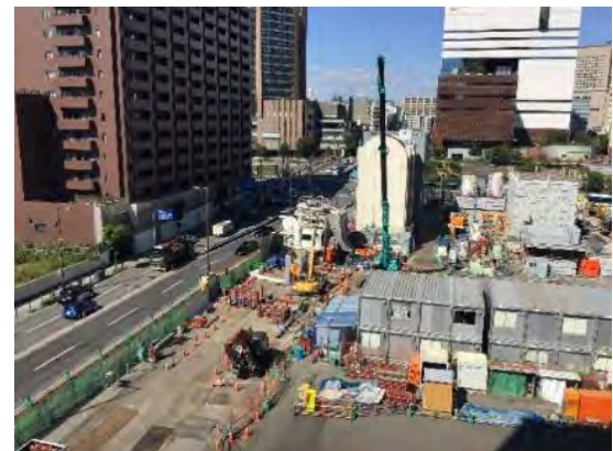
写真 8.14 土留工 (CRM 工法) 施工状況
