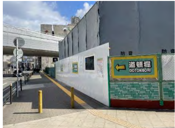
写真 8.4 万能塀設置状況
