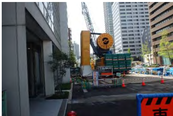
写真 8.13 土留工 (CSM 工法) 施工状況
