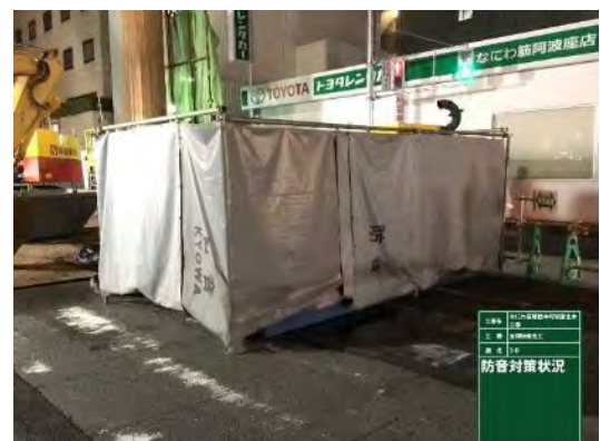
写真 8.8 防音シート設置状況（夜間）
