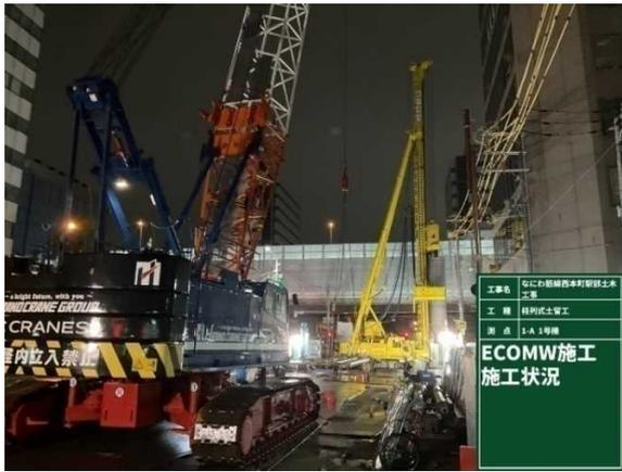
写真 8.11 土留工 (ECOMW 工法) 施工状況
