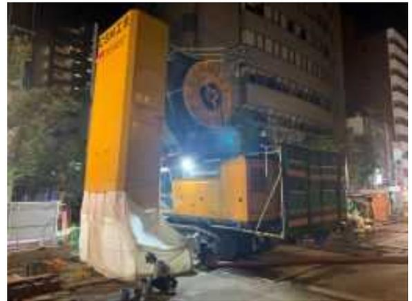
写真 8.12 土留工 (CSM 工法) 施工状況
