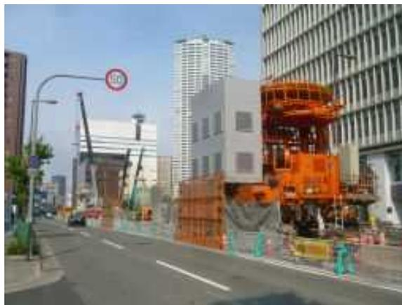
写真 8.13 土留工 (CRM 工法) 施工状況
