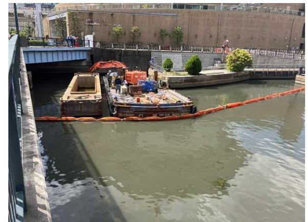
写真 8.14 汚濁防止膜設置状況
