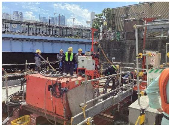
写真 8.15 地盤改良工 (JETCRETE 工法) 施工状況
