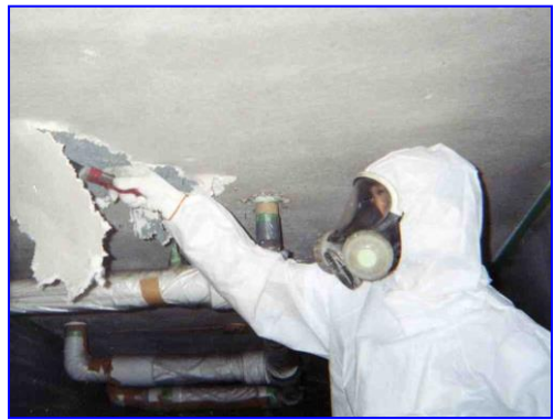
アスベスト除去作業
