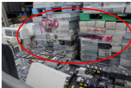
図 16 無停電電源装置 (UPS)
