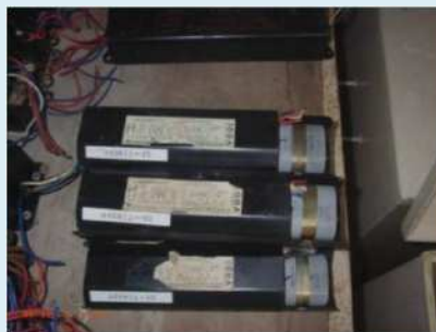
PCB含有のコンデンサ部分を取り外すことができる廃安定器の取り外し作業
