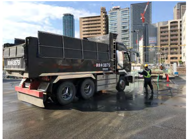
写真4 養生鉄板設置・タイヤ洗浄
