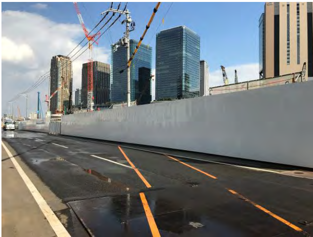
写真3 仮囲いの設置
