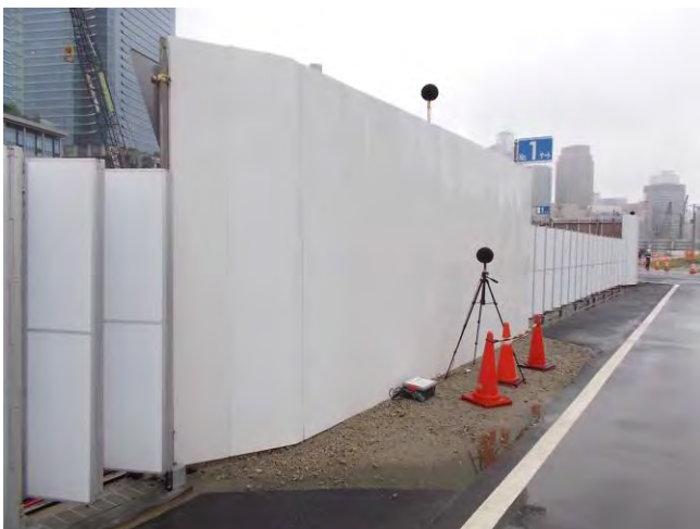
写真5 騒音振動調査の状況
