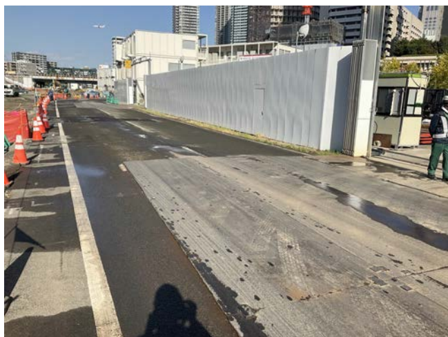
写真3 仮囲いの設置
