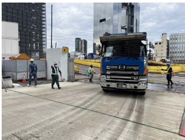
写真5 養生鉄板設置
