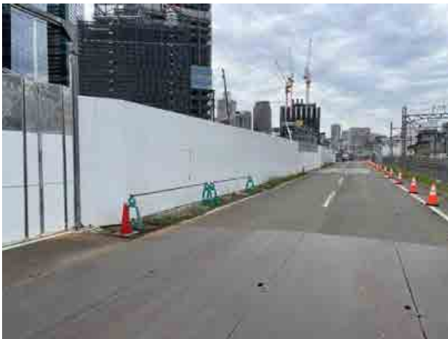
写真3 仮囲いの設置
