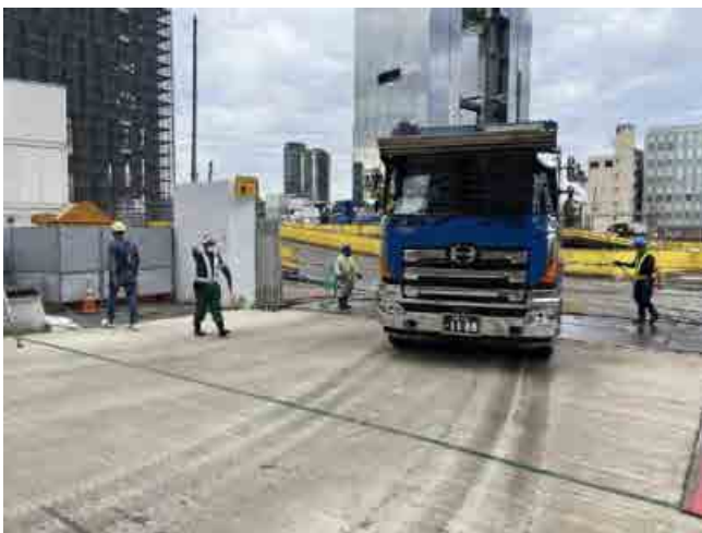
写真5 養生鉄板設置
