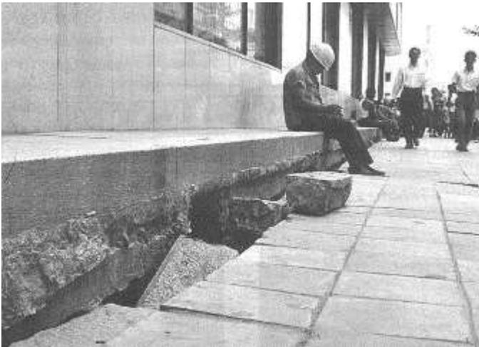
図-2.2.1 地盤沈下によるビルの抜け上がり
