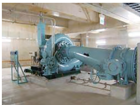
長居水力発電設備
