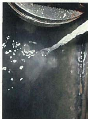
排水処理設備活性炭(1Kg) (設置後)
